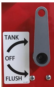
Kuva 1. Venttiili asetettu ottamaan liuosta säiliöstä.
